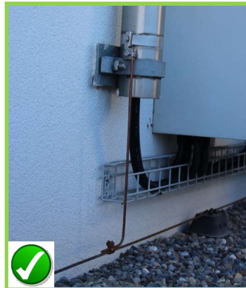
Beispiel Anschluss Mast direkt an Fangleitung
