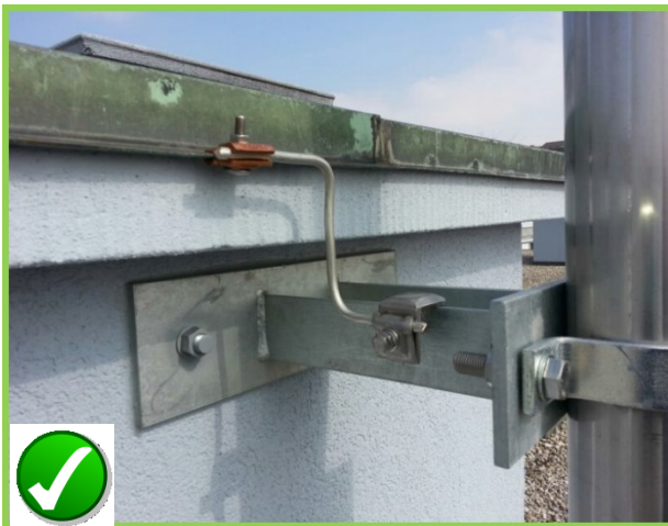
Beispiel Anschluss Mast via Haltevorrichtung an Dachkante
