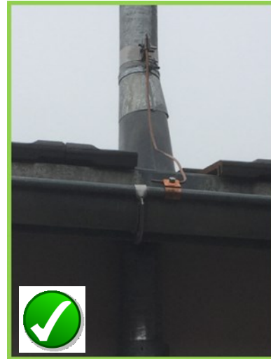
Beispiel Anschluss Mast an Dachwasserrinne
