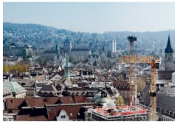
Arbeiten auf Dächern So bleiben Sie sicher oben
