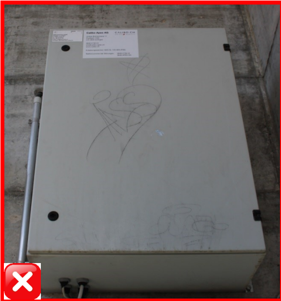
Anordnung der Steuerung im Freien
