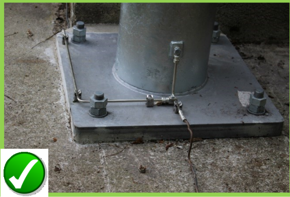
Anschluss einer freistehenden Sirene auf einem Mast
