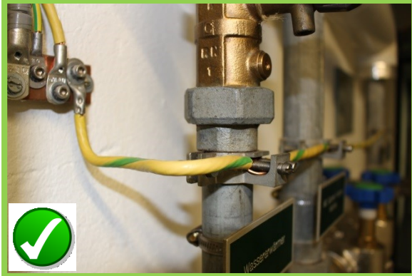
Beispiel Anschluss an den SPA (Schutzpotenzialausgleich)
