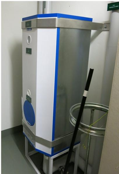
*Boiler mit BZS-Zulassung verfügen über eingebaute Überspannungsableiter. Der Anschluss erfolgt über doppelt abgeschirmte EMP-Kabel direkt in den Boiler.*
