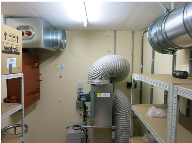
*Ortsveränderlicher Abluftventilator integriert in den Schutzbereich mit Überdruckventilen (UeV) in der Ablufthaube und Explosionsschutzventilen (ESV) im Abluftkasten gegen aussen*
