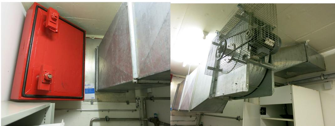
*Ortsfester Abluftventilator separat geführt, Austritt aus der Schutzanlage mittels Panzerdeckel (beim Bezug der Schutzbaute: Kanalstück demontieren, Panzerdeckel schliessen).*
