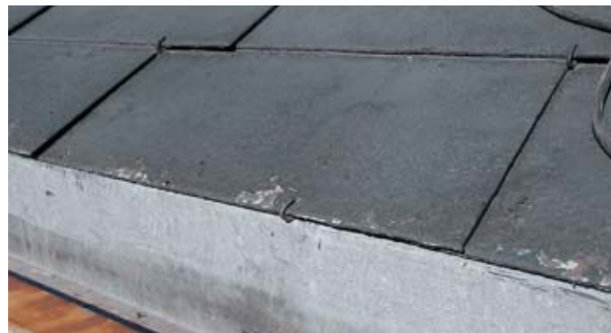
Asbesthaltige Schieferplatten
