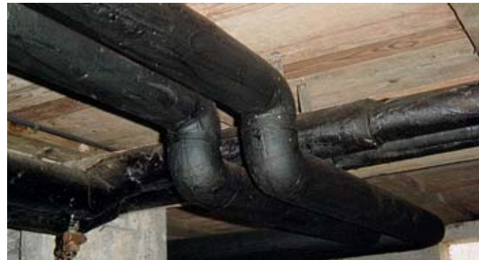
Asbesthaltiger Bitumenanstrich
