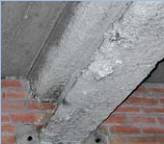
Spritzasbestisolierung
