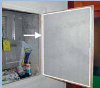
Asbesthaltige Brandschutzplatte
